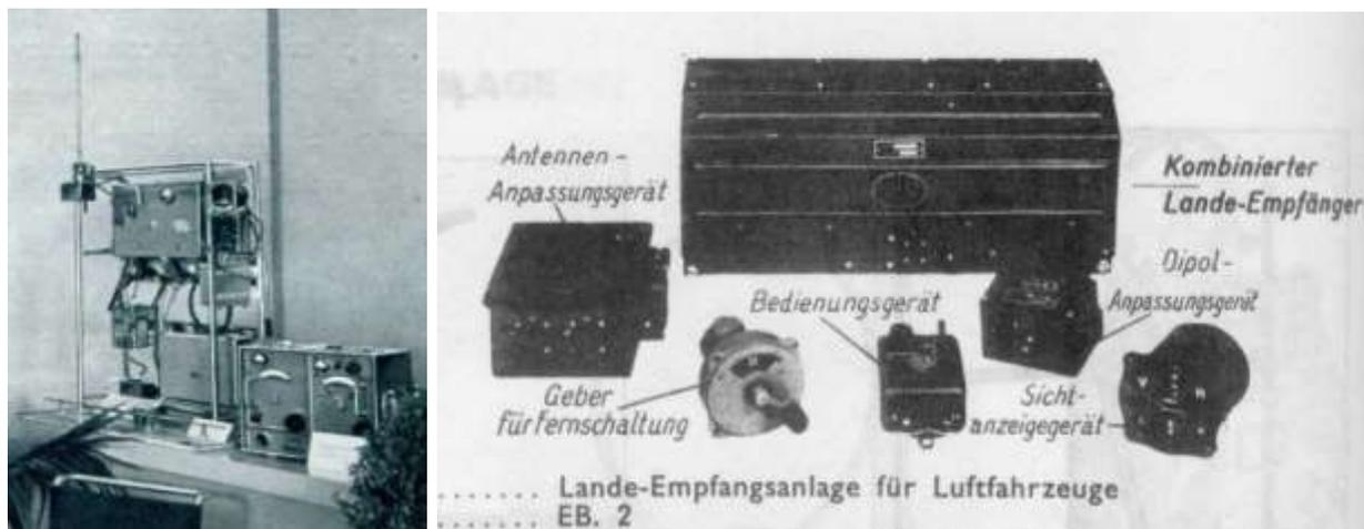
Die verbesserte Anlage EB.2 (Bild rechts) enthielt – wie auch die Telefunken-Anlage 119 N – einen Doppelpfänger für drei wählbare Frequenzen im Bereich 33,3 bis 36,8 MHz und 38,0 MHz (fest). Im zivilen Luftverkehr hatten sich mittlerweile international verschiedene Frequenzen für das Steuerungsfunkfeuer durchgesetzt.
