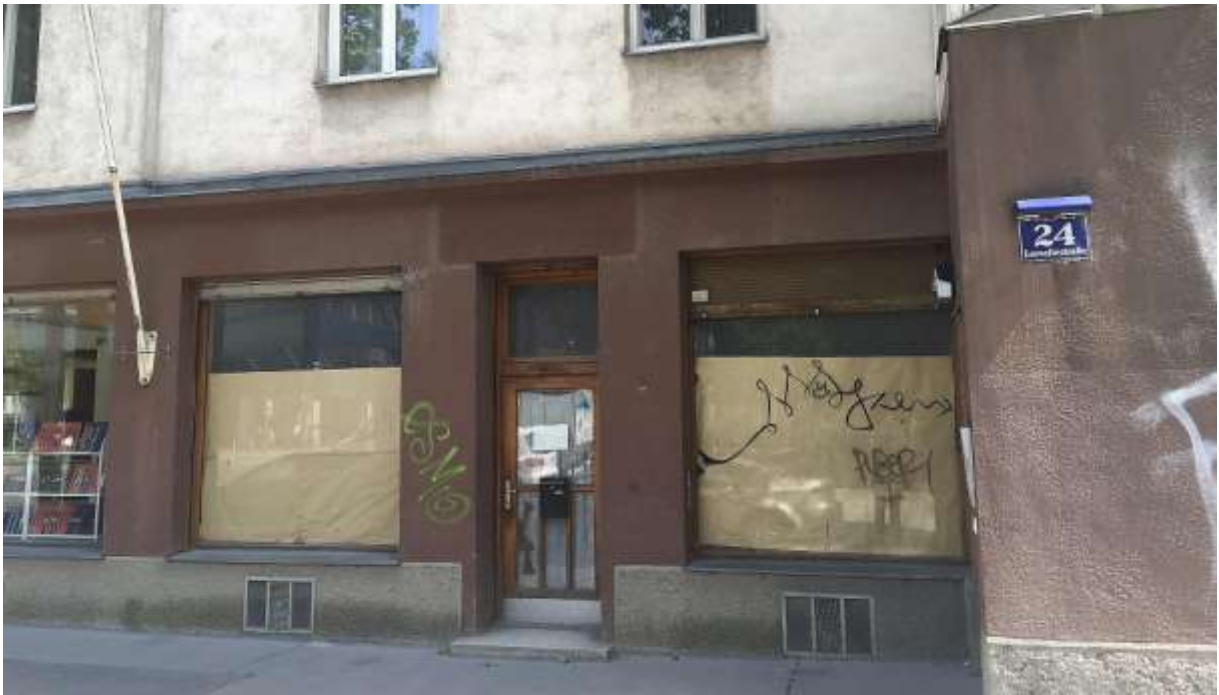
Ansicht des Betriebes, in dem einst Spulen gewickelt wurden. Wie man sieht, sind auch die Nachmieter bereits abgesiedelt und die Räumlichkeiten warten auf neues Leben... (Foto: Christian Haller)
